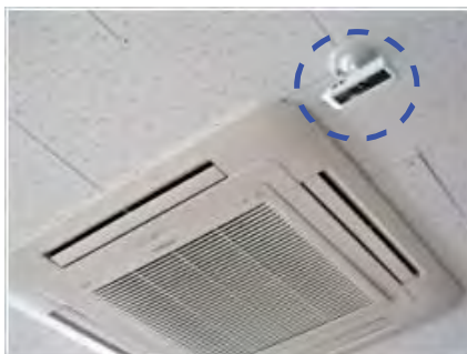
Датчик движения в классе
